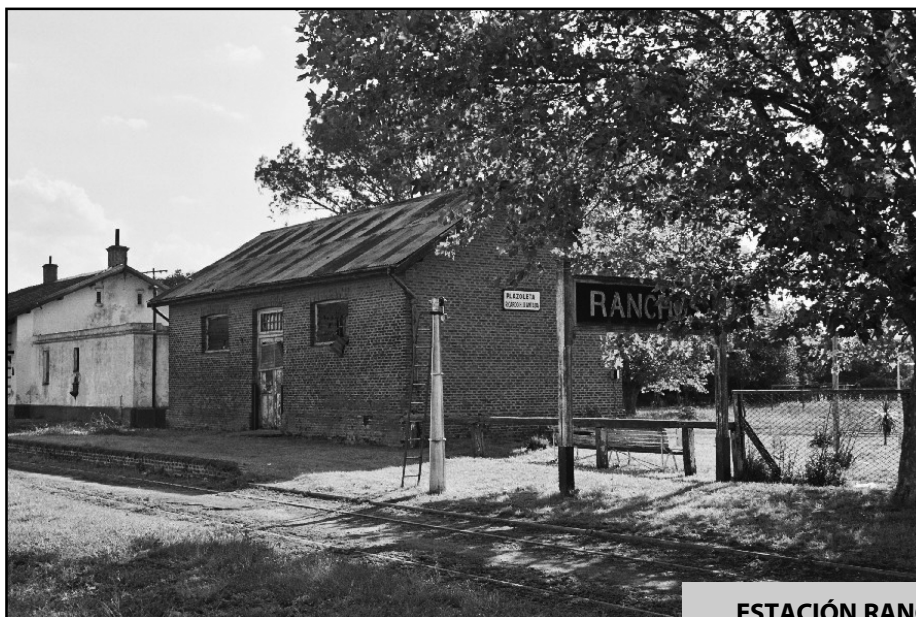
ESTACIÓN RANCHOS, DEF145D
