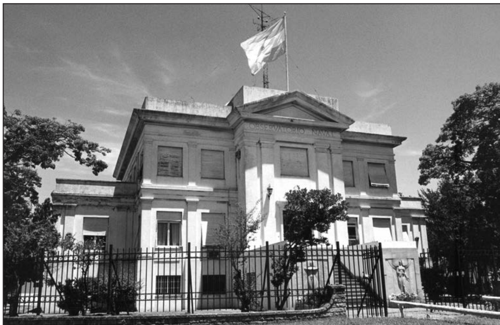
Edificio del Observatorio Naval Buenos Aires, en Costanera Sur
