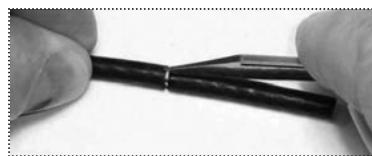
Fig.3: Quitar el aislamiento externo puede hacerse sencillamente cortando cuidadosamente a lo largo de la longitud del cable hasta su fin.
