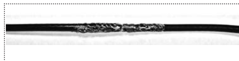
Fig. 11: La malla del lado derecho se ha desplegado sobre la zona de empalme. La del lado izquierdo se desplegará encima de la anterior entrelazándolas de forma de restituir la malla.
