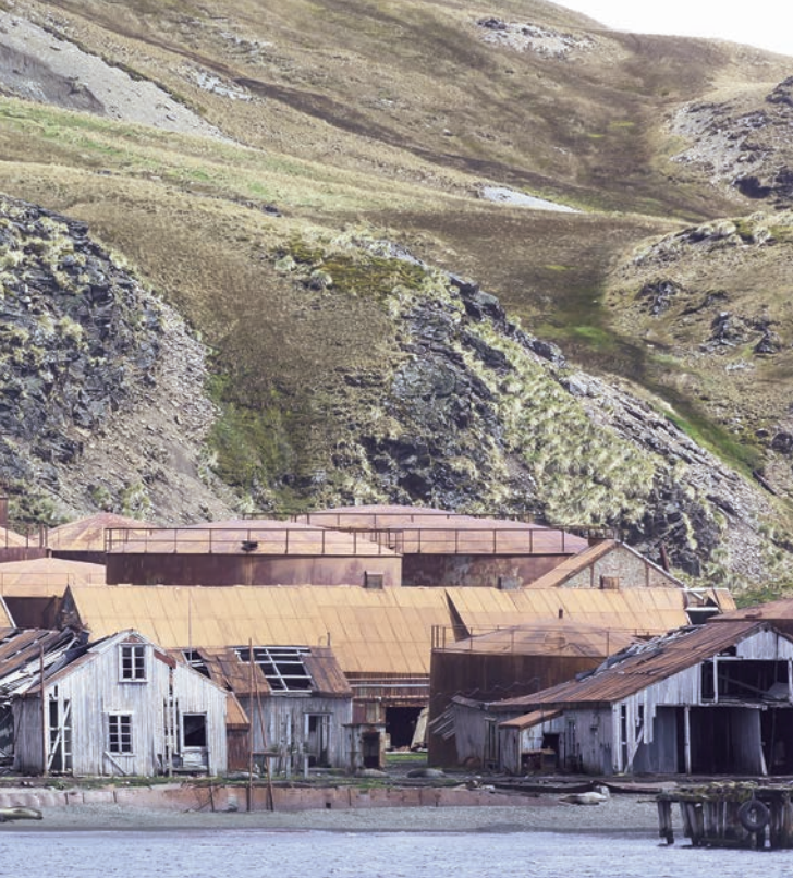
La factoría ballenera de Puerto Leith
