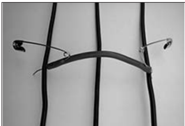
Figura 5: Conexión provisoria del puente.
