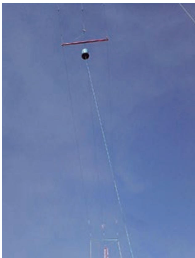
Vista de la antena L invertida con bobina a tope para LF.
